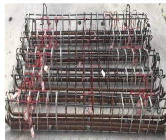
(a) 钢筋笼绑扎
