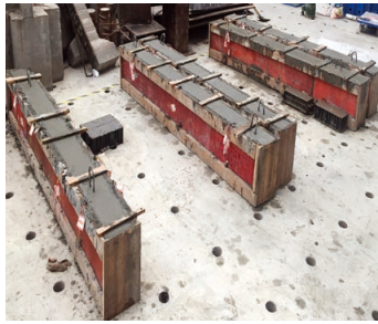
(c) 混凝土浇注
