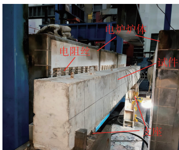
图3 火灾试验试件安装状态
