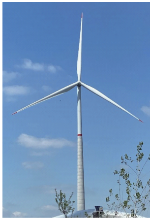
图1 钢-混凝土混合结构塔筒
