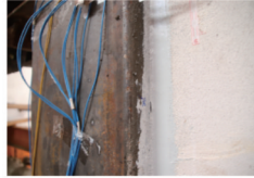
c) 背面板5中上部与柱连接处密封胶分离
