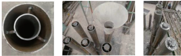
a) 内、外钢管对中与夹层混凝土浇筑
