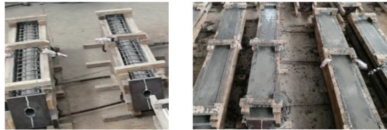
b) 钢筋笼绑扎、模板支护与外部混凝土浇筑
