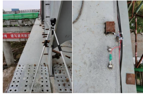
图11 主桁架的变形和应力测试
