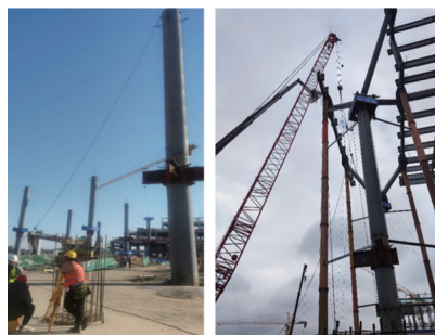
图11 钢柱安装现场
