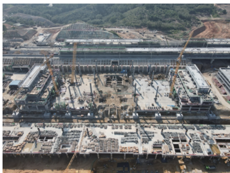
图4 钢屋盖施工现场航拍图
