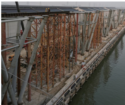
图22 滑移支承结构现场照片
