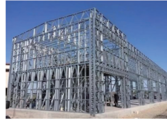
a) 中国冷弯薄壁型钢结构厂房
