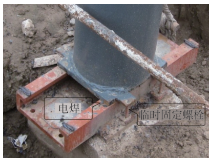
图15 摇摆柱临时固定措施图
