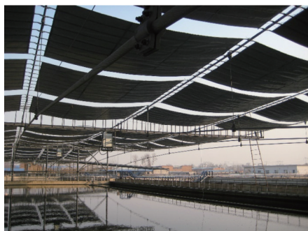
图16 良乡污水处理厂太阳能光电建筑应用示范项目
