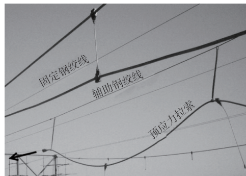
图13 水上拉索施工作业图 Fig. 13 Water-based construction drawing of cable
