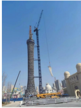
图9 塔吊附着实景
