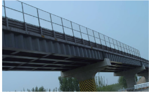
图1 大庆—广州高速公路6号立交桥
