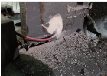
图6 试件BRB破坏形态
