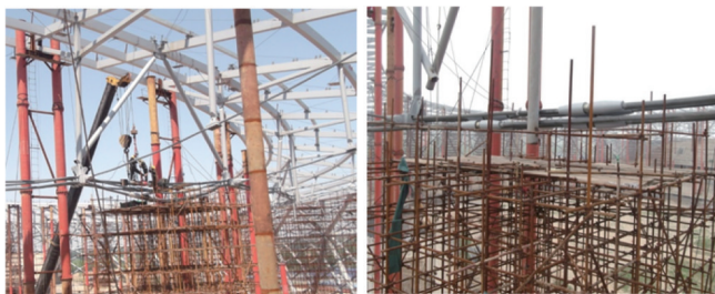
图14 环向索分段提升高空对接现场施工
