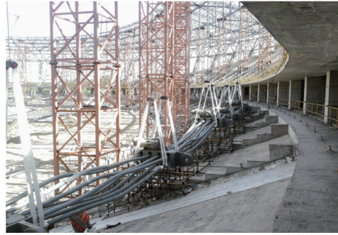
图6 索网整体提升施工
