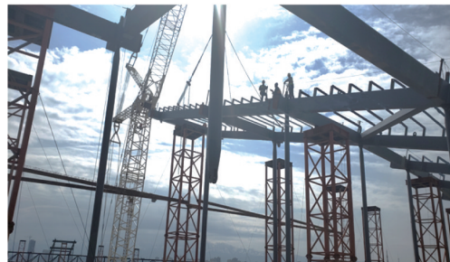
c) 现场施工图
