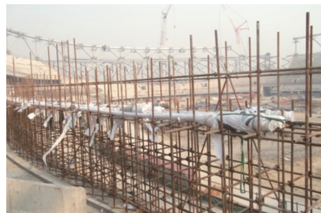
图16 环向索地面拼装措施现场施工
