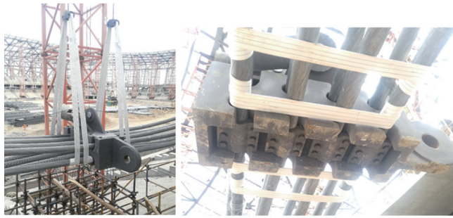
a) 下吊点绑扎整体图 b) 下吊点绑扎细节图
