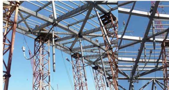
图15 径向索牵引安装现场施工
