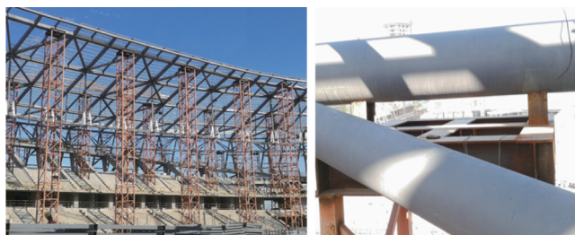
a) 支撑架整体布置图
