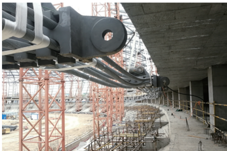
图17 环向索有障碍提升现场施工
