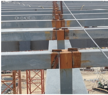
图29 檩条低应力安装现场施工
