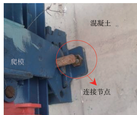
图 1 爬模连接节点
