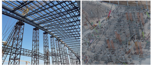
a) 屋盖提升实景图 b) 分段吊装实景图
