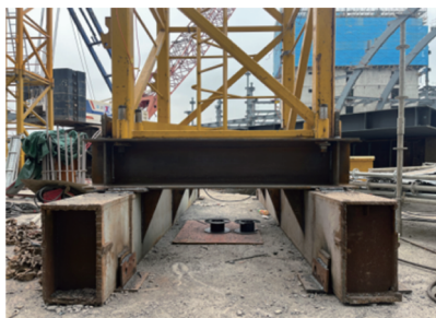
图17 支撑架与转换钢梁连接
