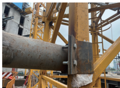
图18 支撑系统抱箍
