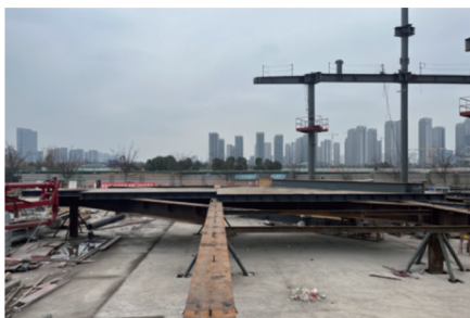
图13 钢栈桥现场施工
