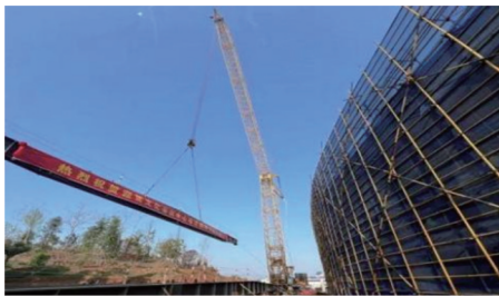
a) 预应力钢梁吊装
