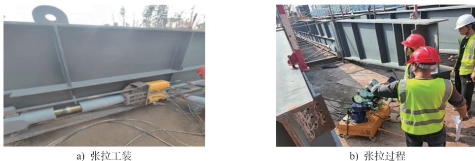
图8 张拉施工
