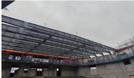
b) 预应力钢梁安装过程
