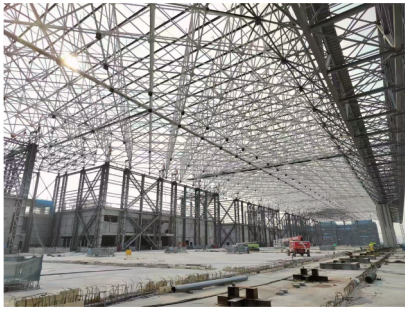
图 23 跨中无支撑提升现场施工
