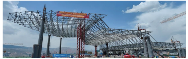
图3 三级台阶式网架
