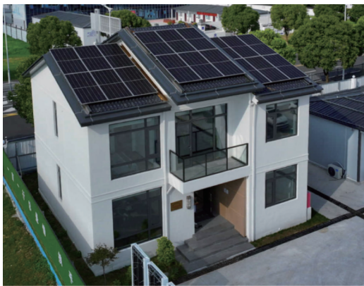
图 17 钢结构模块化乡村宜居房实际案例
