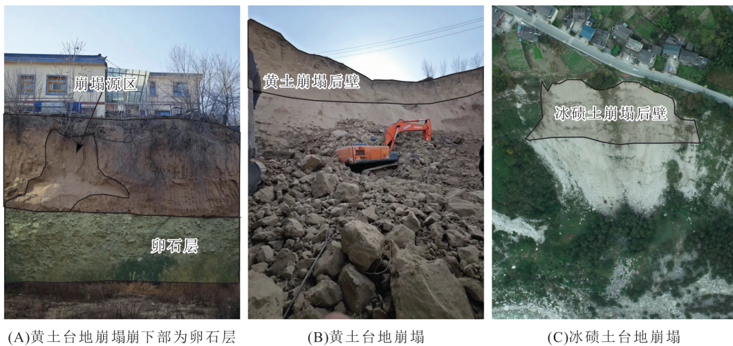
图 11 黄土台地和冰碛土台地崩塌
