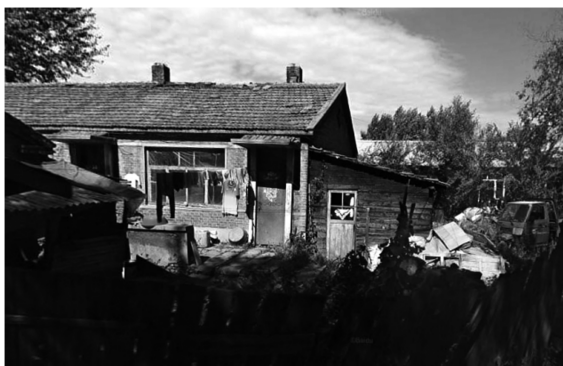
图 6 鹤岗市南山区奋斗路实景(2024 年)
