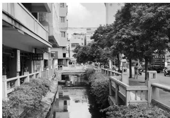
图7 深涌中支涌现状照片
