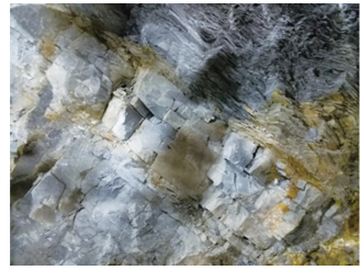
图6 IV级围岩段掌子面
