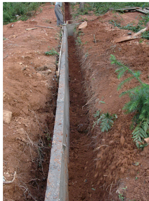
浇筑水泥隔离竹鞭 供图 / 岳祥华
