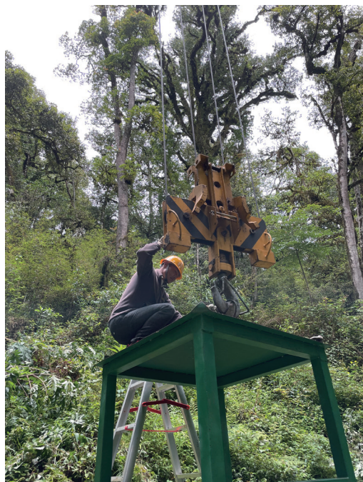
连接塔吊吊篮（上）及安全措施（下）
