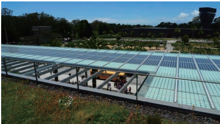
屋顶四周的太阳能电池板
