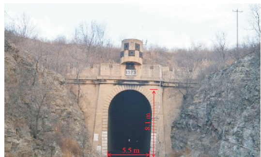
图 1 既有隧道入口
