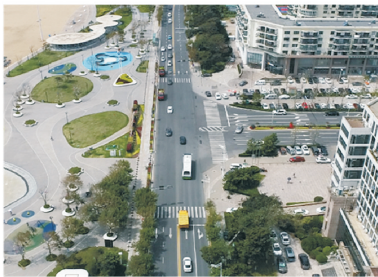
(a) 交叉口现状
