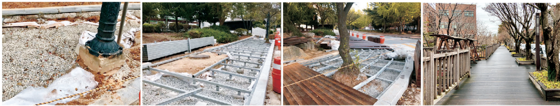
图6 渗透木栈道施工过程
