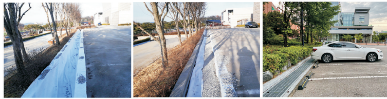
(b) 施工过程
