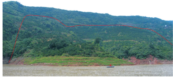
图 3 树坪滑坡全貌 [13]
