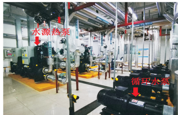
图 2 渗流海水源热泵机房布置
