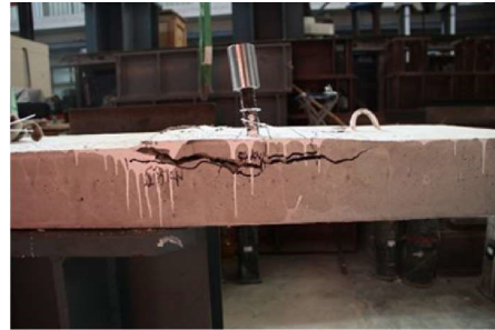
(a) 锚栓上方混凝土掀起
