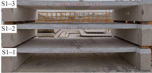
(a) 新型板跨中裂缝发展形态
