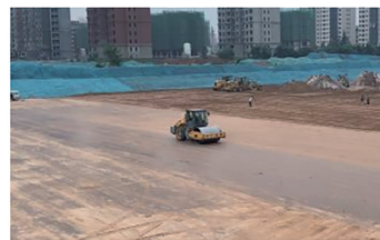
(c) 回填碾压施工过程
