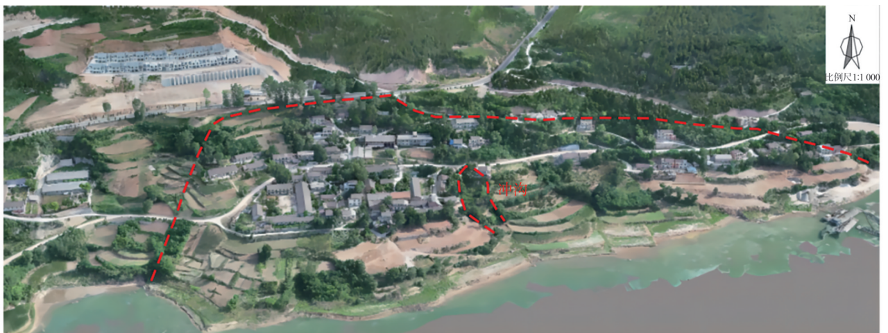
图1 金岗村滑坡全貌
