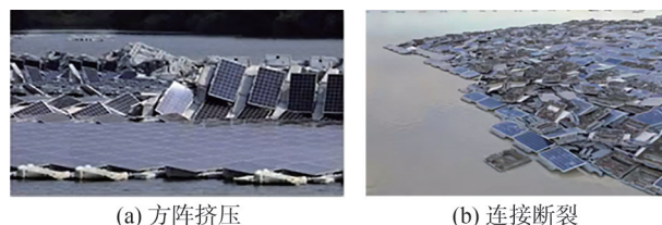
图3 光伏阵列破坏现象
