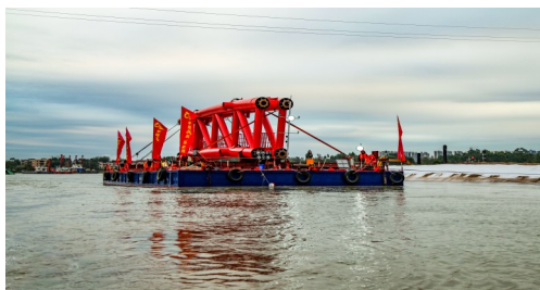
图2 大型施工构件水上运输
