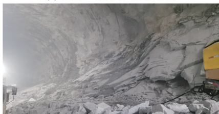
(b) 叶巴滩, 围岩劈裂剥落
