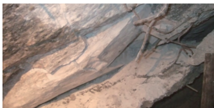
(a) 锦屏一级, 围岩劈裂弯折
