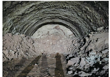
图 2 下寨隧道现场围岩情况
