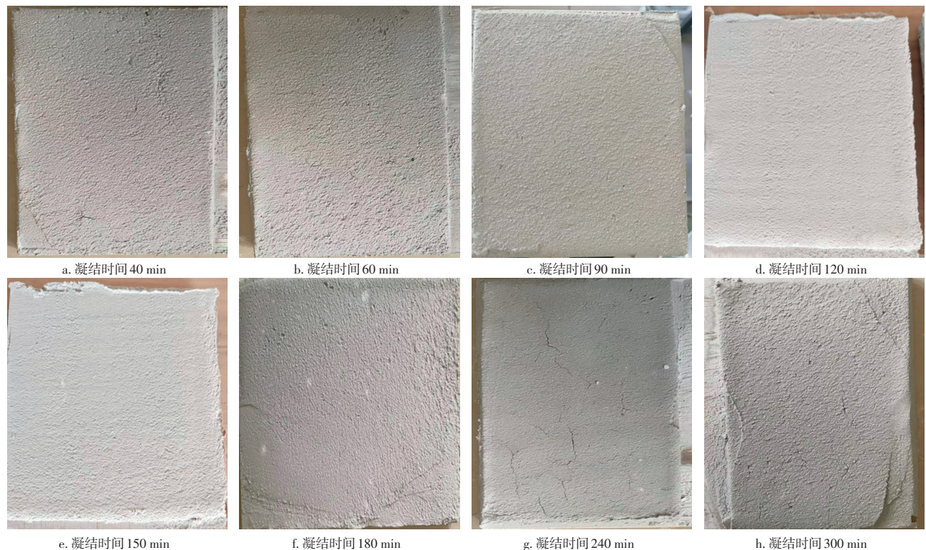
图 6 不同凝结时间下的抹灰石膏开裂情况
